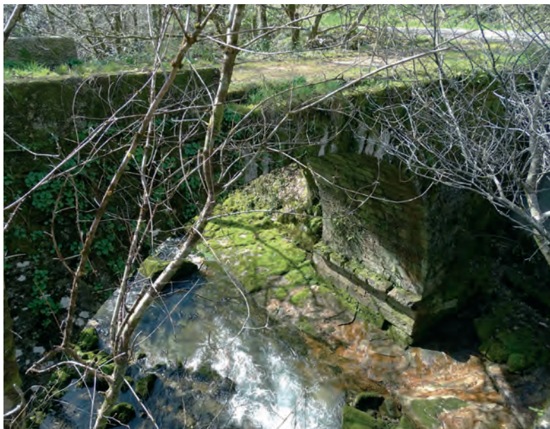
Vista oblicua da Ponte de Vilanova
