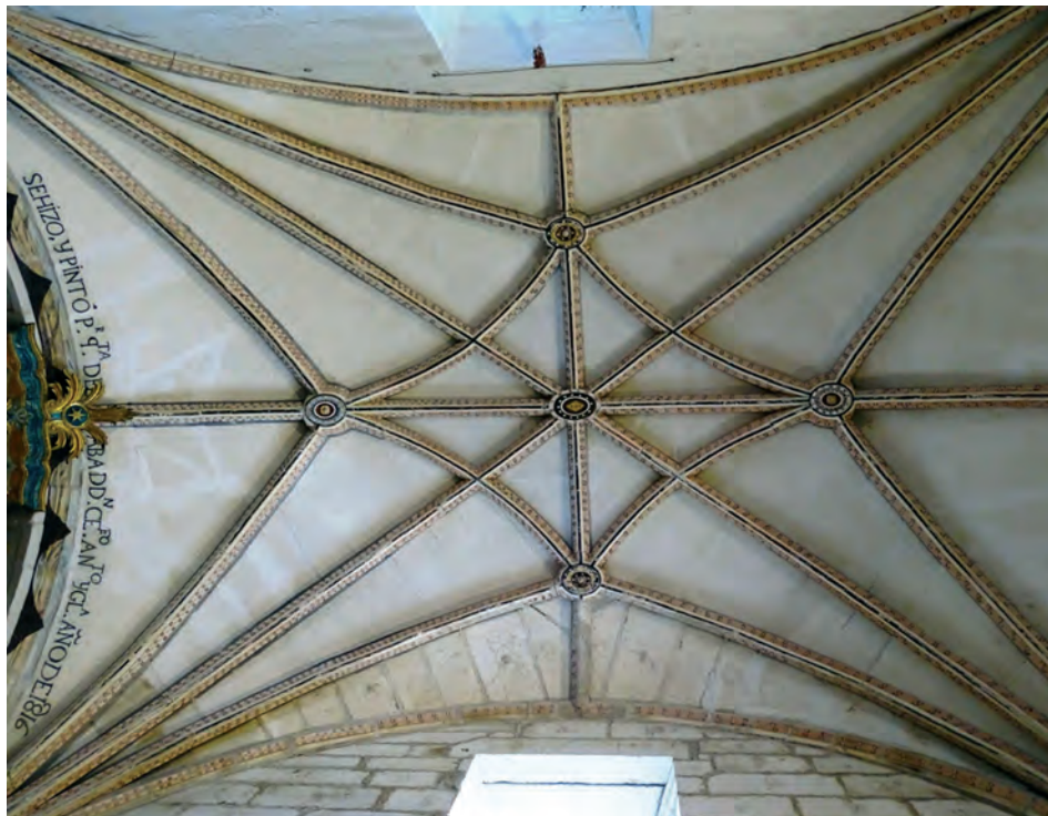
Detalle da bóveda nervada que cubre o presbiterio
