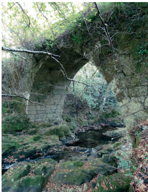
Alzado da Ponte de Portafurado, augas abaixo
