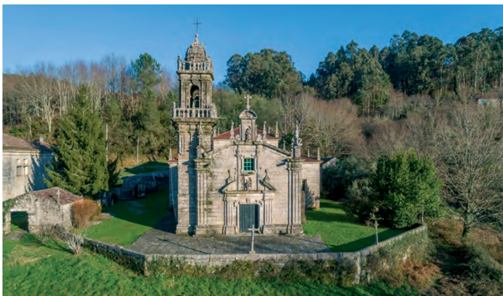
Fachada oeste do templo
